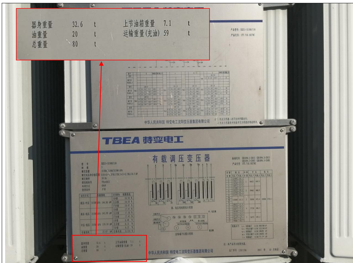
图 7-4 梓口坊 110kV 变电站 1 号主变铭牌及油量
