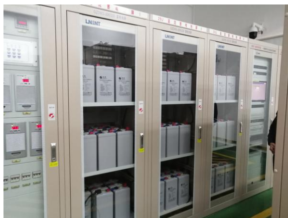
图 7-2 梓口坊 110kV 变电站站内铅酸蓄电池
